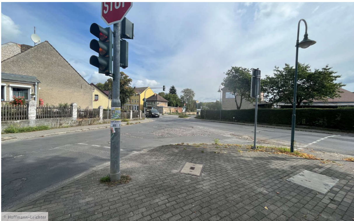
Bild 6 KP 2 Berliner Straße / Schönfließer Straße | Blickrichtung Nordosten
