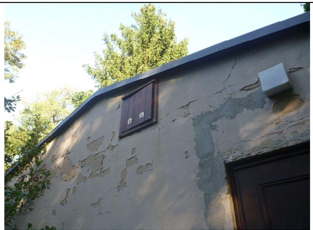
Abbildung 28: Spalt an der Dachluke des Ju-
