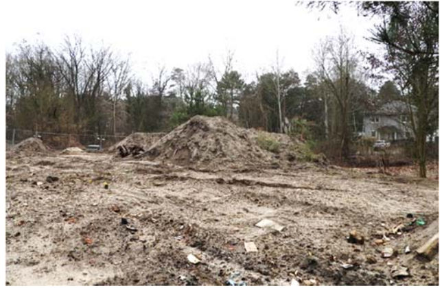
ehemalige Müllablage (nördlicher Teil) mit angelegten Schürfunken zur Bodenuntersuchung
