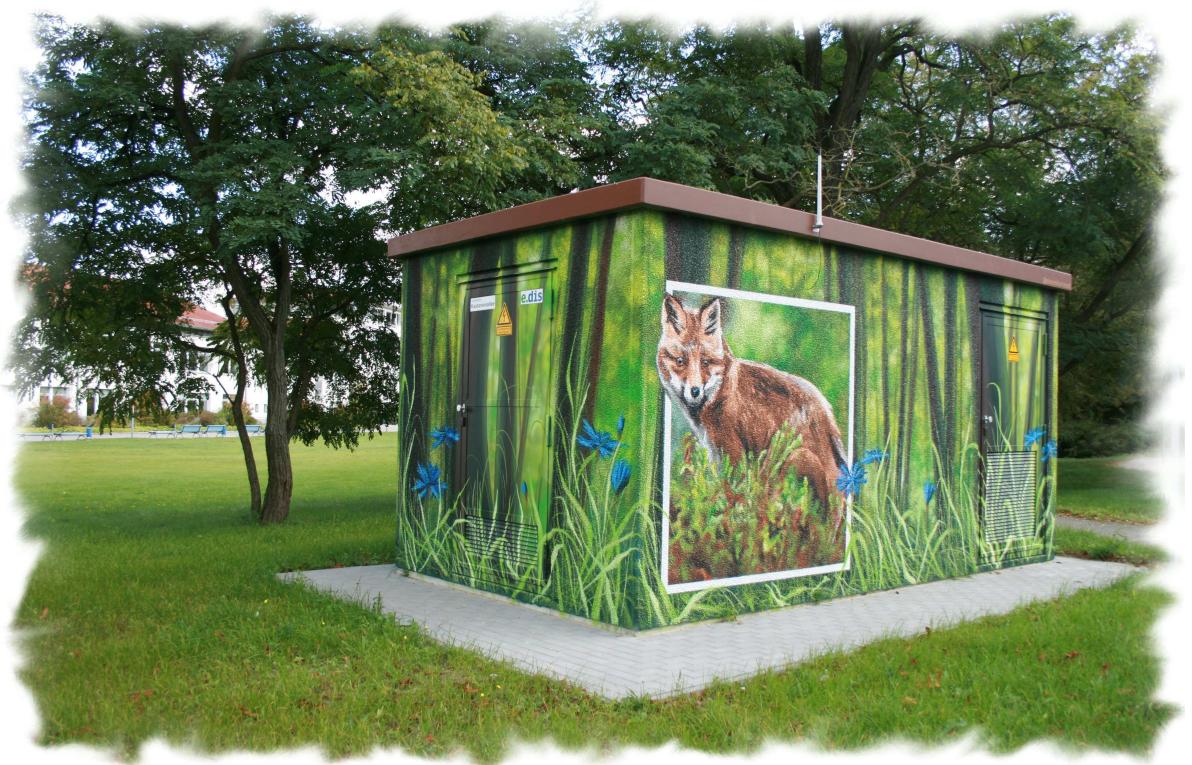
Neugestaltete Trafostation am Berufsförderungswerk
