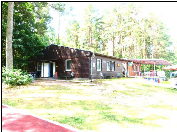
Klub- und Sanitärgebäude im Süden des Plangebietes
