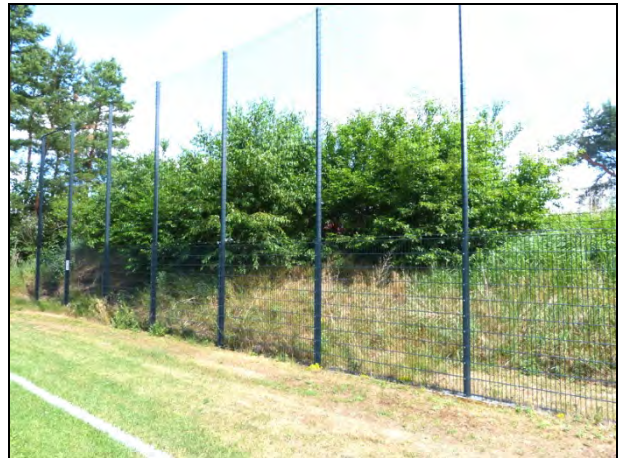
Erdwall nördlich des Fußballtrainingsplatzes
