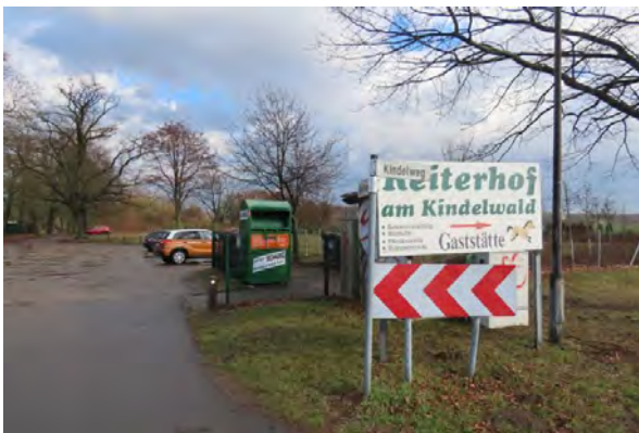
Abb. 2: Blick entlang des Weges „Am Reitweg“ im Norden
