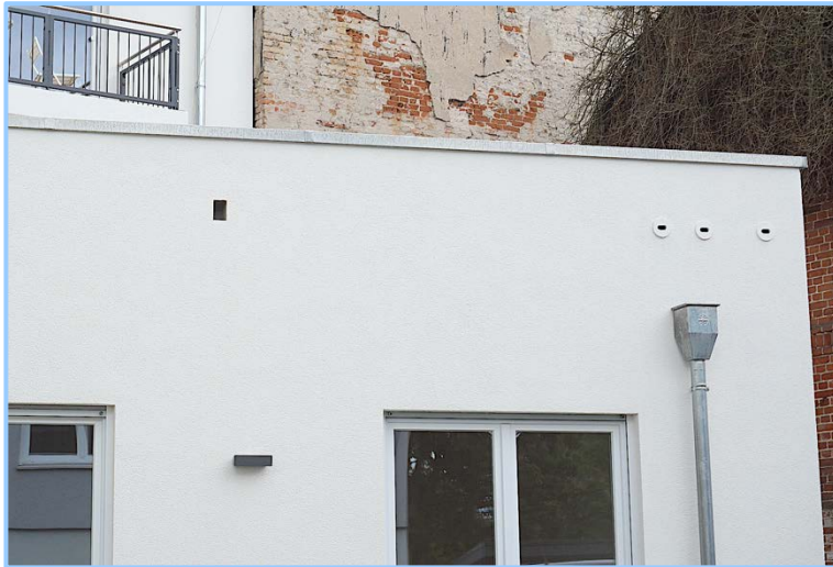
Abb. 31: Integration von einem Mauerseglerkasten 17A, dreifach und einer Halbhöhle 1HE für Hausrotschwänze in einen Neubau. Tino-Schwierzina-Str. 5 in Berlin-Heinersdorf, 2021.
