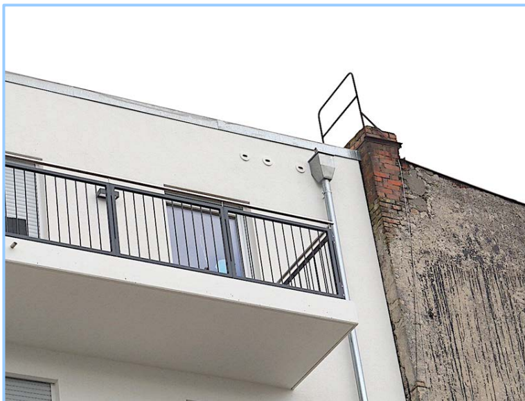
Abb. 30: Integration von einem Mauerseglerkasten 17A, dreifach in einen Neubau. Tino-Schwierzina- Str. 5 in Berlin-Heinersdorf, 2021.
