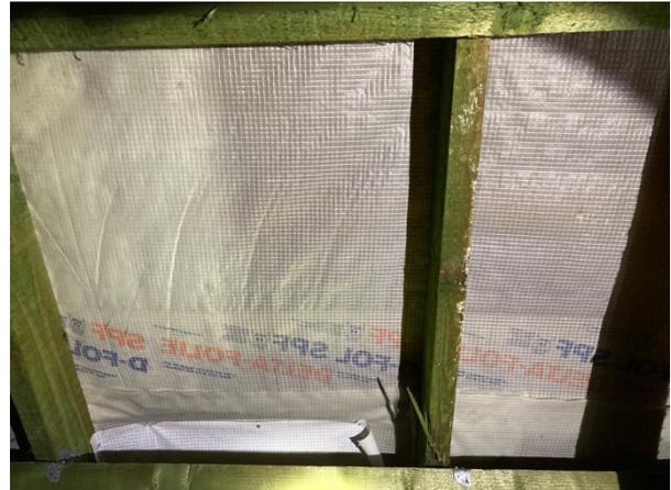
Abb. 9: Folienverkleidung am inneren Dach
