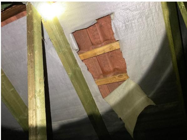
Abb. 10: Schaden in der Folienverkleidung
