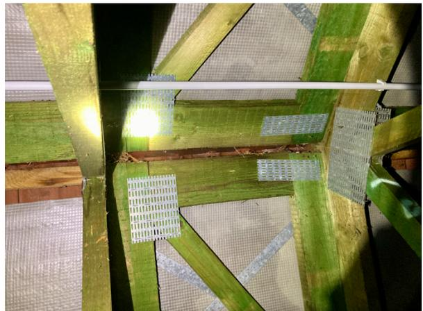
Abb. 7: Der Dachstuhl wurde aus imprägniertem Holz errichtet
