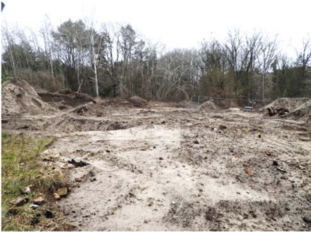
ehemalige Müllablage (nördlicher Teil) mit angelegten Schürfunken zur Bodenuntersuchung
