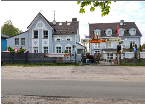
Wohnhaus und Hotel / Restaurant, Ansicht von der Hermsdorfer Straße (Südseite)
