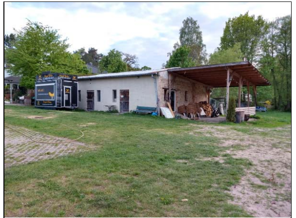
Nebengebäude, Ansicht von Nordost
