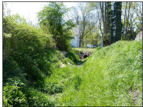
Kienluchgraben angrenzend an das Plangebiet mit Verrohrung nördlich der Schönfließener Straße und unter der Schönfließener Straße, Blick von Nord (Mai 2016)
