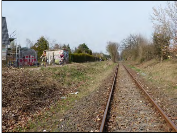
Bahnlinie Heidekrautbahn angrenzend an den südlichen Teil des Plangebietes, Blick von Süd, hier ist die Bahnlinie eingesenkt und es ist kein Gehölzbestand vorhanden
