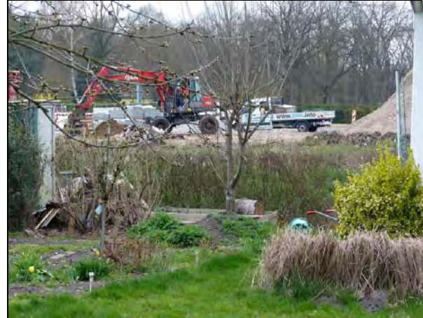
Unruhe im Plangebiet durch westlich benachbarte Bautätigkeit - Blick über den Kienluchgraben nach W.
