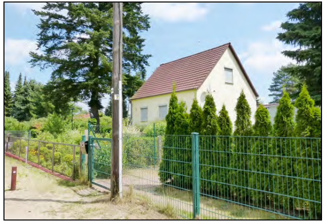
Wohnbebauung am Grünen Weg östlich des Plangebietes
