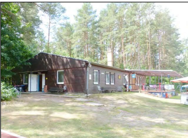
Funktionsgebäude, Blick von Nordost
