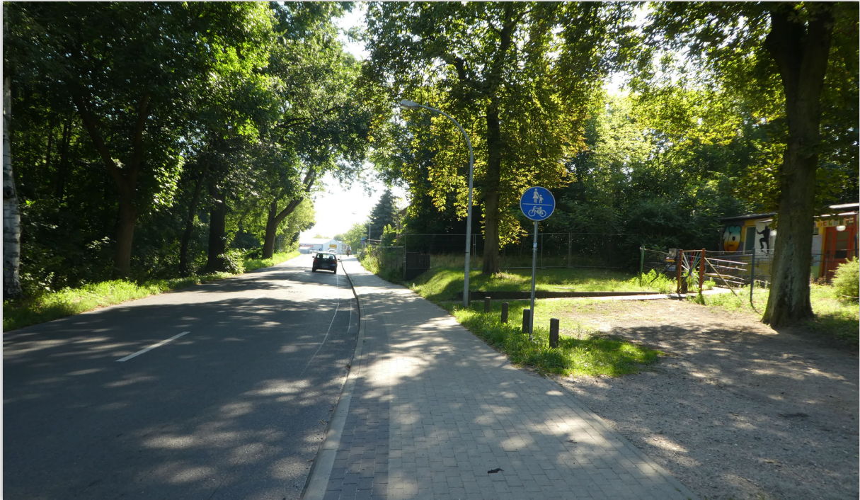
Abbildung 2-4 Gemeinsamer Geh- und Radweg entlang der Bahnhofstraße (L30) | Blickrichtung Osten
