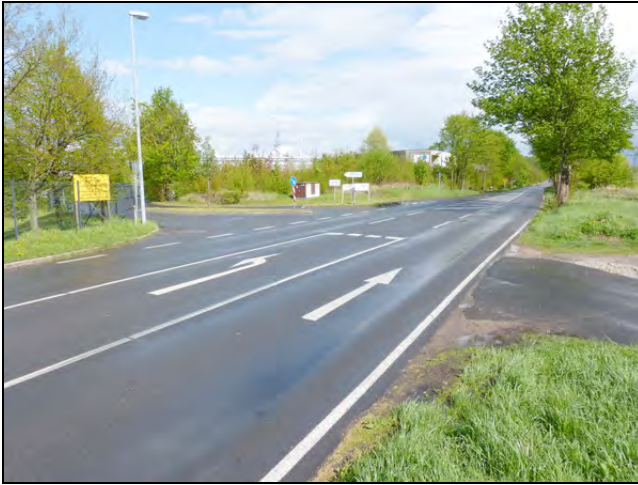
L 305 mit Einmündung der Straße Am Hasensprung und der Zufahrt auf der Seite des Plangebietes, Blick nach Ost (April 2018)
