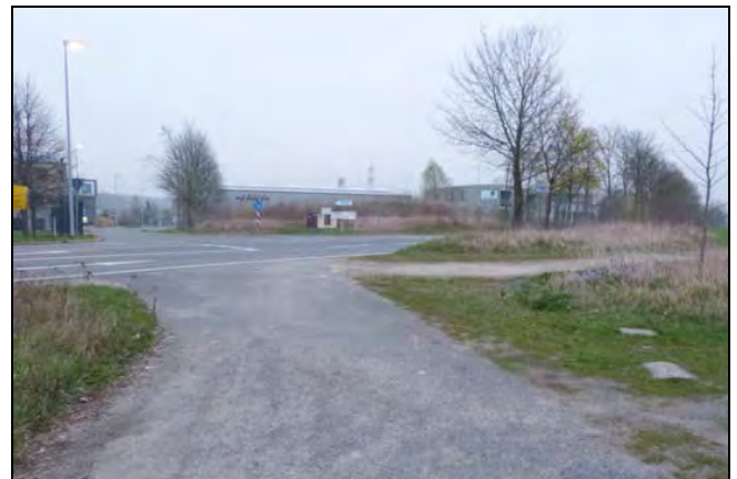
Zufahrt zum Plangebiet von der Landstraße L 305 (Foto Januar 2017)
