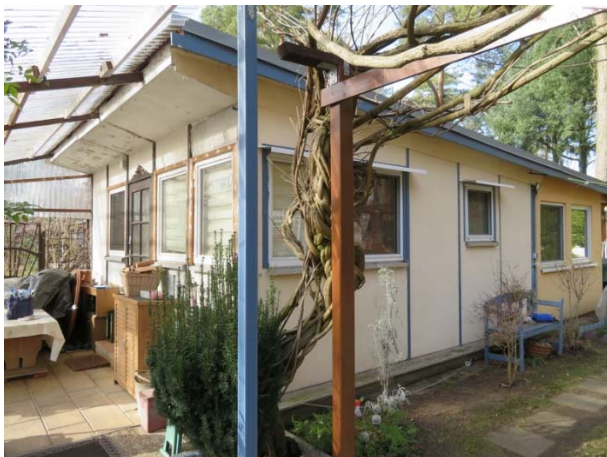
Fuchsgasse 10 mit Baufeld 11 Nebenglass im NW des Südteils Flst.1181
