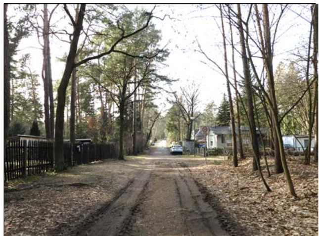
Neue Bahnhofstraße, unbefestigter Teil östlich der Feldstraße, Blick nach West
