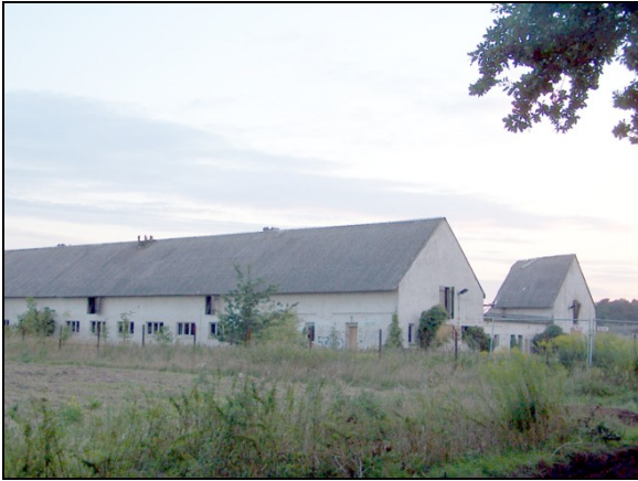
Südwestlich des Plangebietes befindet sich ein früherer Rinderstall, der ungenutzt ist
