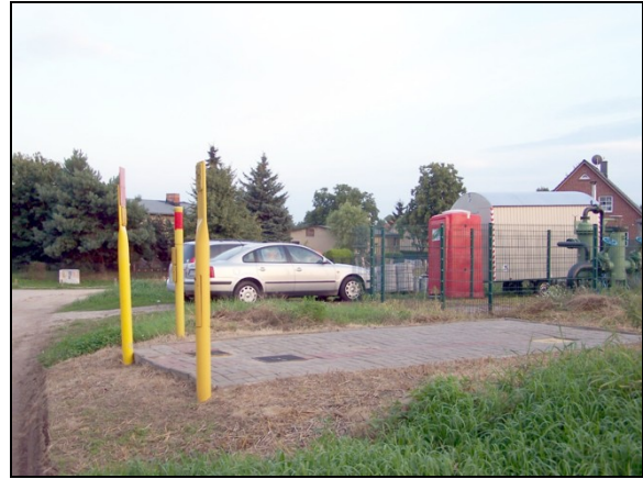
Südlich des Plangebietes ist eine Gasverteilerstation mit Filterblock vorhanden, von der aus Ferngasleitungen entlang der Birkenwerder Straße südlich des Plangebietes sowie in nördlicher Richtung das Plangebiet querend bis zum Kirschweg verlaufen.
