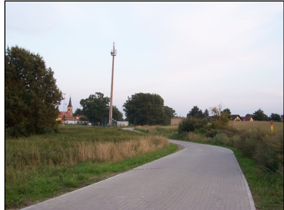
Kirschweg, Blick nach Süd
