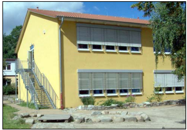
B Neues Schulgebäude Grundschule
