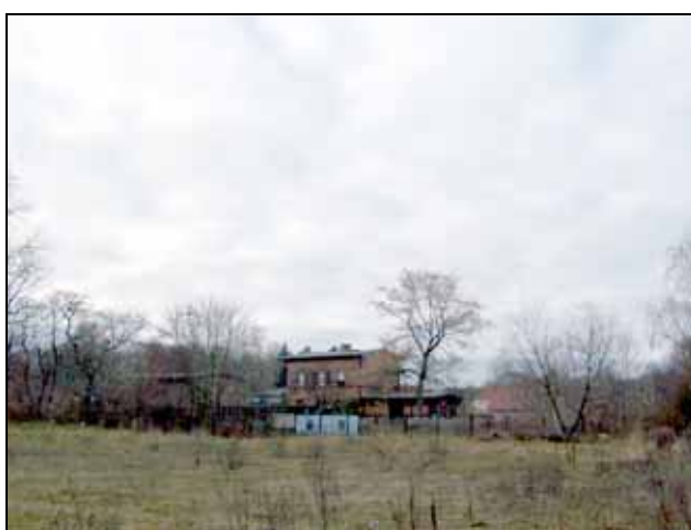
Blick Richtung Südwest, Richtung Bahnhofsgebäude
