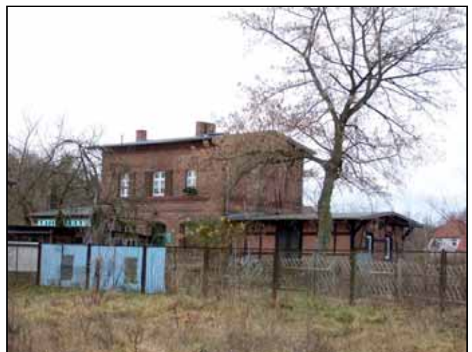
Linde auf der östlichen Seite der Ladestraße
