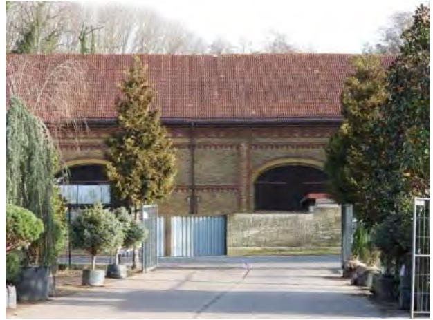
Zufahrt vom östlichen Teil des Gewerbehofes zur Dorfstraße – Blick nach Ost
