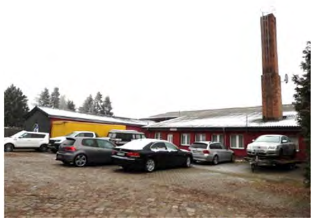
Blick nach Nordost vom Plangebiet zum nördlichen Teil der Gewerbebebauung
