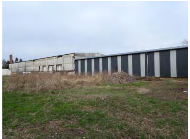
Blick von Südwest zur Gewerbebebauung
