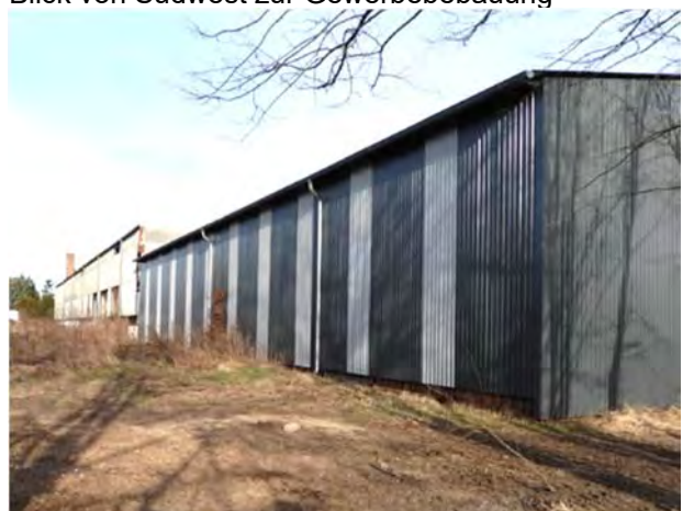
Blick von Südwest zur Gewerbebebauung
