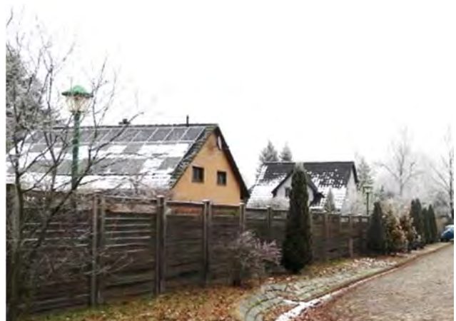
Blick vom Plangebiet zur Wohnbebauung nördlich des Schulweges
