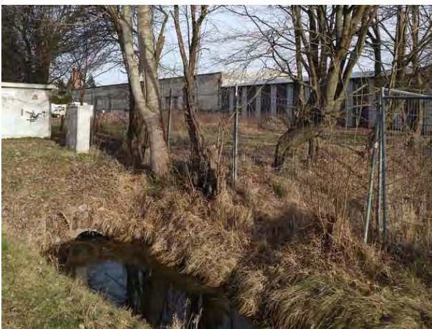
Blick über den Graben am Feldweg zum Graben südlich des Plangebietes
