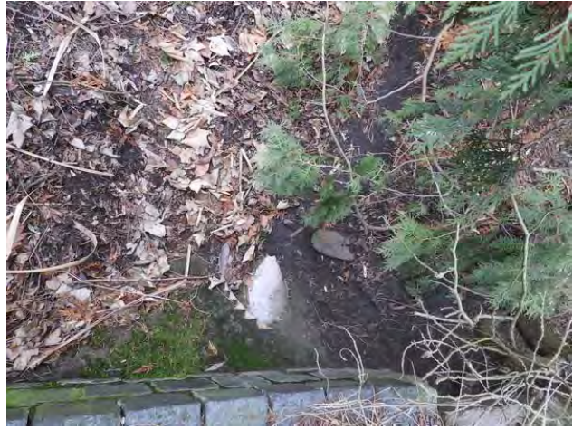
Blick von der Dorfstraße über das Gelände zum Grabendurchlass des Grabens, der südlich des Plangebiet verläuft
