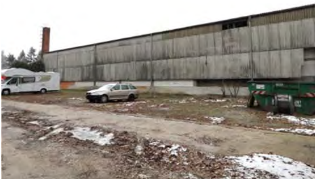
Blick von Südwest zur Gewerbebebauung
