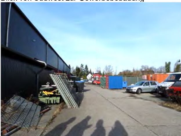
östlicher Teil des Gewerbehofes, Blick von Süd
