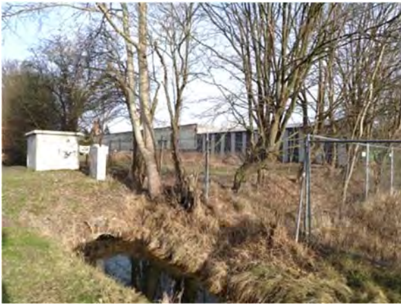
Trafostation am Feldweg südwestlich des Plangebietes, Blick von Südwest
