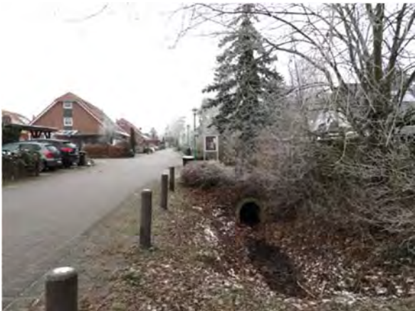
Blick von Süd zur Verrohrung des Grabens am Feldweg unter der bestehenden Zufahrt zum Plangebiet
