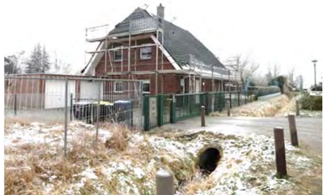
Wohnbebauung östlich des Feldweges, südlich des Plangebietes, Blick nach Südwest
