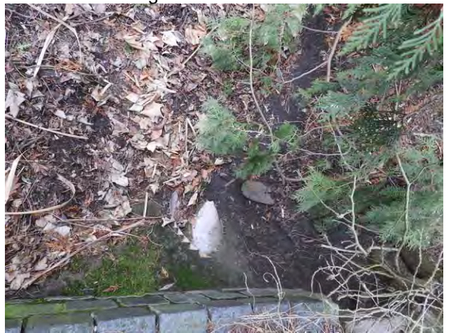
Blick von der Dorfstraße über das Geländer zum Grabendurchlass des Grabens, der nördlich des Plangebietes verläuft
