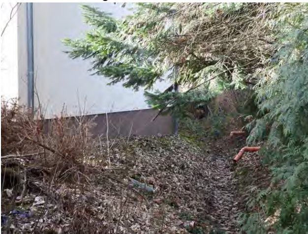
Blick von der Dorfstraße in den östlichen Teil des Grabens, der nördlich des Plangebietes verläuft
