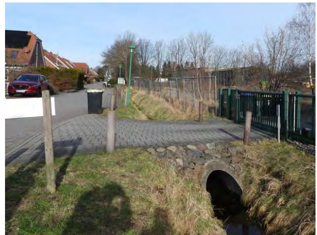
Rohrdurchlass Graben am Feldweg, Grundstückszufahrt südlich des Plangebietes
