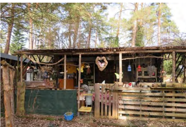
Hauptgebäude im Baufeld 7 Blick aus Süd
