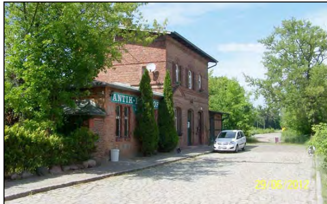
denkmalgeschütztes früheres Bahnhofsgebäude an der Ladestraße (heute Wohnnutzungen) Blick von Süd (Foto 2012)
