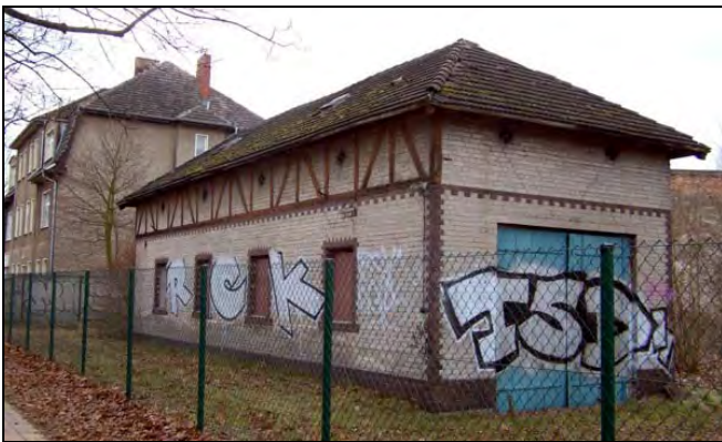
Gebäude an der Schönfließener Straße im Süden der bisherigen bebauten Gewerbefläche, Blick aus Nord (Foto 2008)
