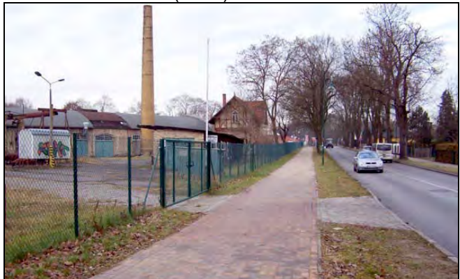
vorhandene Zufahrt in der Mitte des Plangebietes (Foto 2008)
