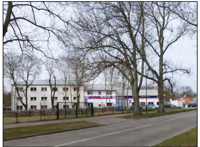
Ansicht von Ost (Foto 2015)
