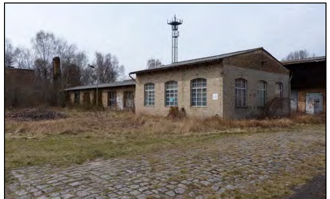
Sozial- und Bürogebäude von Nordost (Foto 2015)
