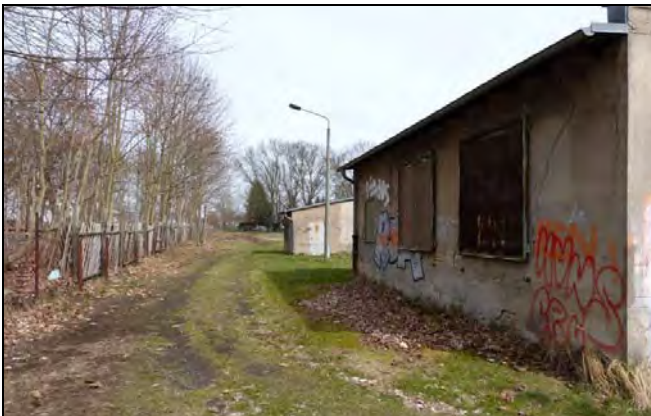
gepl. eingeschränkte Gewerbefläche im Nordteil des Plangebietes – Fläche zwischen Heidekrautbahn und vorh. Bebauung - Blick nach N
