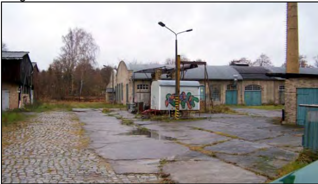
Blick von der Schönfließer Straße nach West (Foto 2008)
