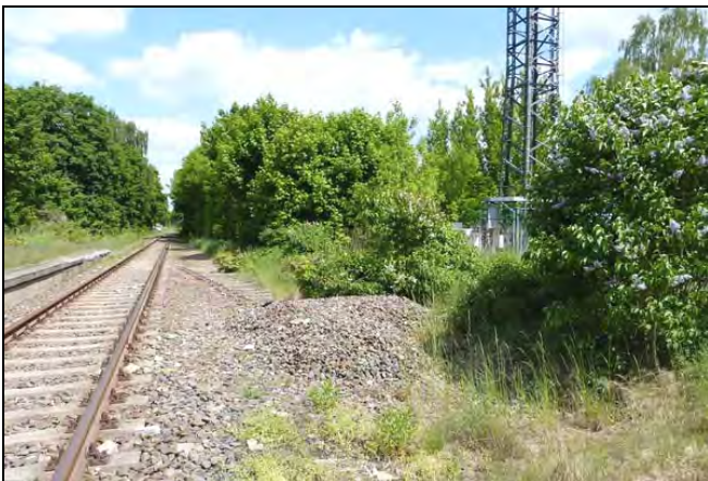
Bahnlinie im Bereich des Plangebietes, Blick von Süd (Foto 2015)
