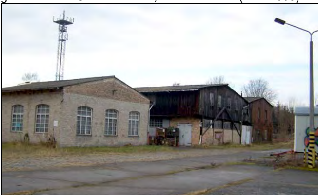
Blick von der Schönfließener Straße nach Südwest auf die südliche Bebauung der bisherigen bebauten Gewerbefläche (Foto 2008)
