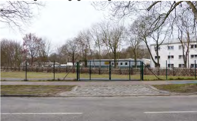
vorhandene nördliche Zufahrt (Foto 2015)
