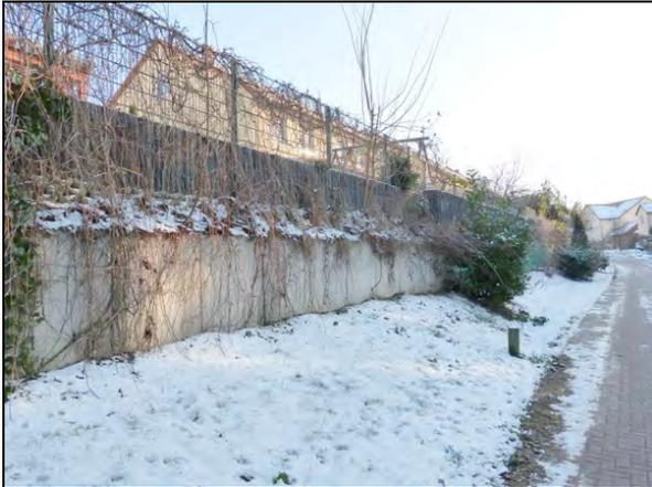
Stützwand aus Winkelsteinen mit aufgesetzten Formsteinen aus Beton und darüber befindlicher Einzäunung an der Ebereschenstraße (nördlicher Teil)
