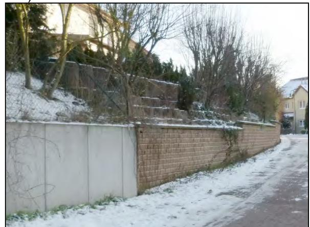
Ringstraße, Mitte, Ostseite, Übergangsbereich zwischen Stützwand aus Winkelsteinen mit darüber liegender Böschung und Stützwand aus Bossensteinen mit Aufbauten aus zusätzlichen Hangsteinen aus Beton
