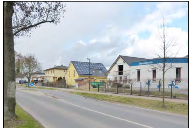
Wohnbebauung und Tierarztpraxis nordöstlich der Schönfließer Straße, westlich der Heidekrautbahn, westlich des Plangebietes
