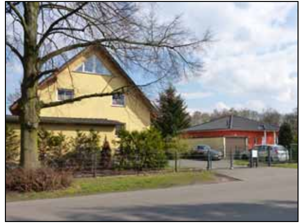
Wohnbebauung Florastraße westlich des Plangebietes
