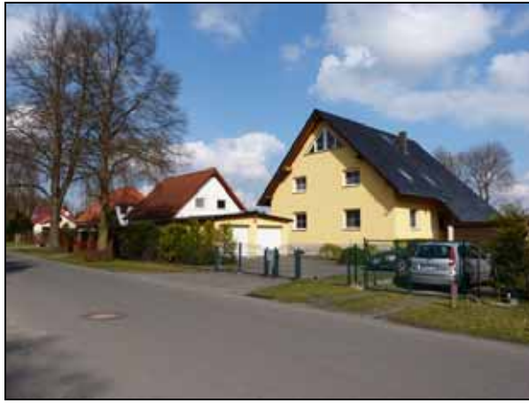
Wohnbebauung Florastraße westlich des Plangebietes
