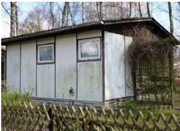
Gartenlaube / Erholungsbungalow aus Asbestzementplatten
