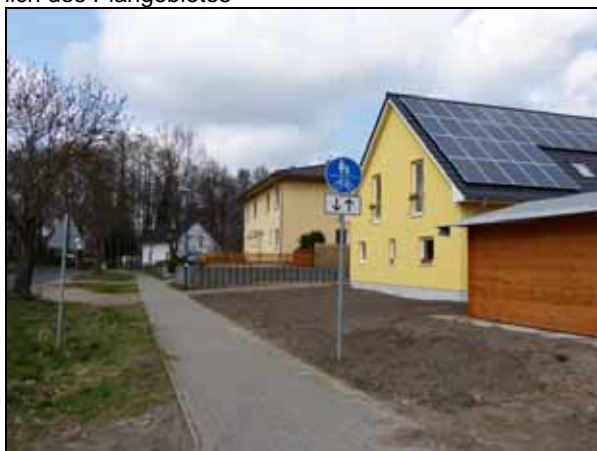
Wohnbebauung Schönfließener Straße südöstlich des Plangebietes
