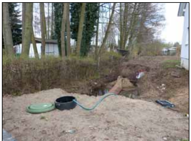
Verrohrung des Kienluchgrabens nördlich der Schönfließer Straße im März 2014
