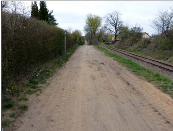
Weg an Ostgrenze des Plangebietes ist durch Baufahrzeuge sehr zerfahren.
