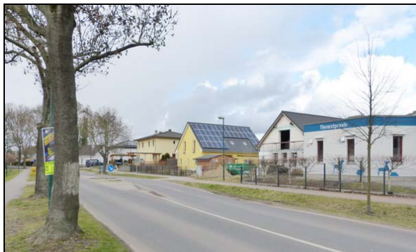
Wohnbebauung und Tierarztpraxis nordöstlich der Schönfließer Straße südlich des Plangebietes
