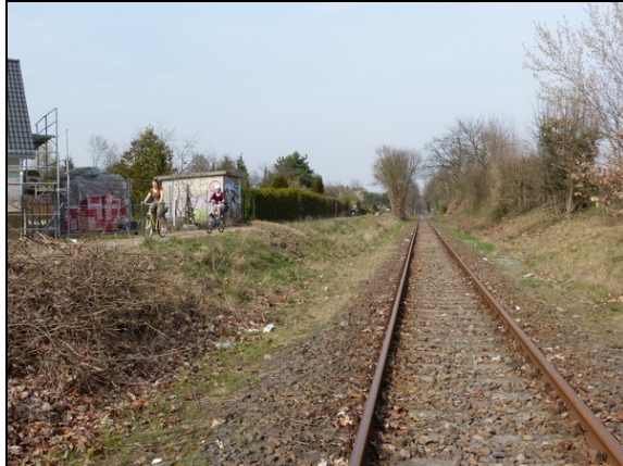
Bahnlinie Heidekrautbahn angrenzend an den südlichen Teil des Plangebietes, Blick von Süd, hier ist die Bahnlinie eingesenkt und es ist kein Gehölzbestand vorhanden
