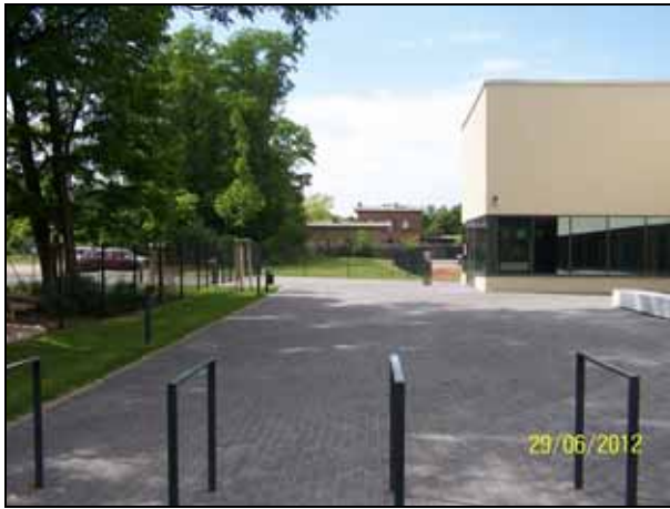
Blick von Ost auf die Fahrradstellplätze und Feuerwehraufstellfläche im nordöstlichen Teil des Plangebietes, rechts im Bild der Eingang der Sporthalle, die selbst außerhalb des Plangebietes liegt, links im Bild schließt sich die Fläche der Kita an, die im Plangebiet liegt
