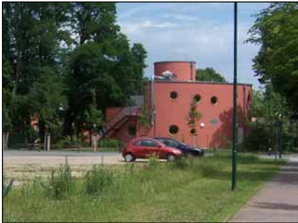
Blick von Südwest über das Plangebiet zum Kita-Neubau im Plangebiet
