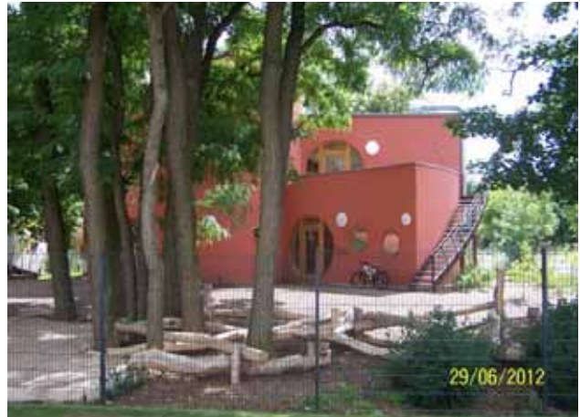
Blick von Nordwest zum Kita-Neubau im Plangebiet
