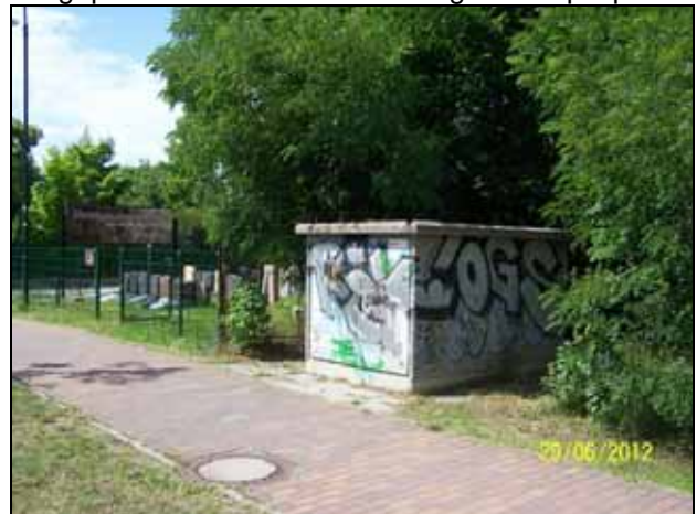
Trafo an der südwestlichen Ecke im Plangebiet, dahinter das angrenzende Bahngelände, das durch einen Steinmetz genutzt wird
