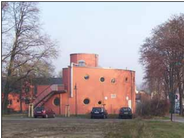
Blick von West auf den Neubau der Kita (innerhalb des Plangebietes), dahinter liegt der Altbau der Kita (außerhalb des Plangebietes)
