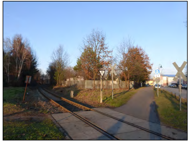
Blick von Süd auf die Querung des Fußweges der Franz-Schmidt-Straße und der Bahnlinie südlich des Plangebietes
