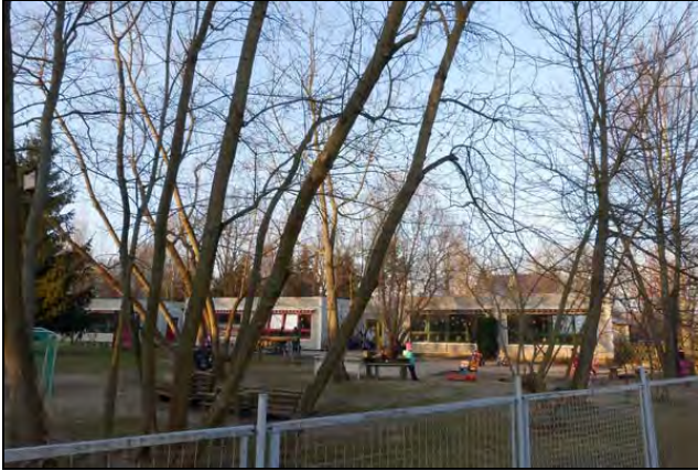
vorhandene Kita, Ansicht von Süd
