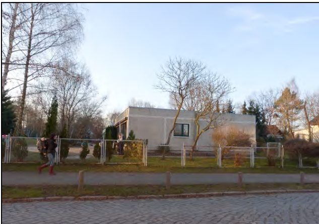
vorhandene Kita, Ansicht von Ost
