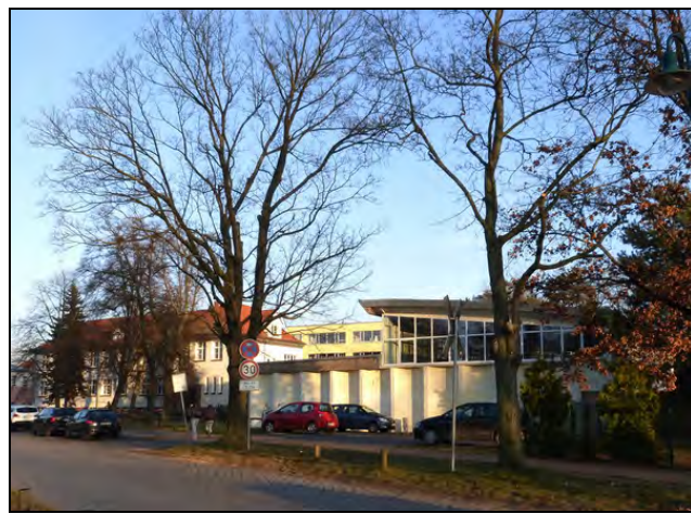
Turnhalle südöstlich des Plangebietes auf der gegenüber liegenden Seite der Franz-Schmidt-Straße
