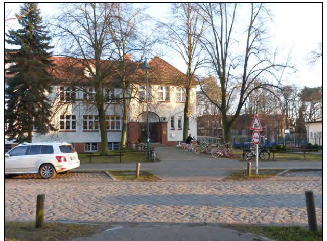
derselbe Übergang, Blick vom Plangebiet zur Grundschule
