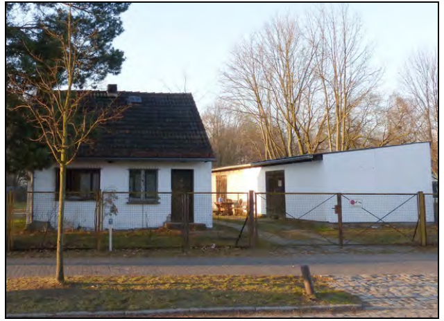
Gebäude auf dem südlichen Teil des Plangebietes, Blick von Ost
