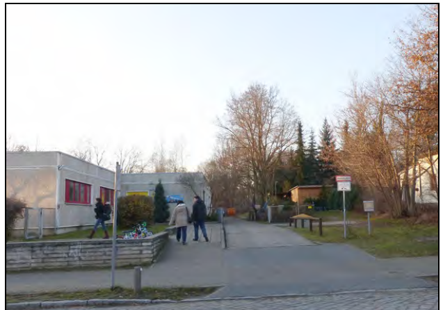
vorhandene Kita, Ansicht von Nordost
