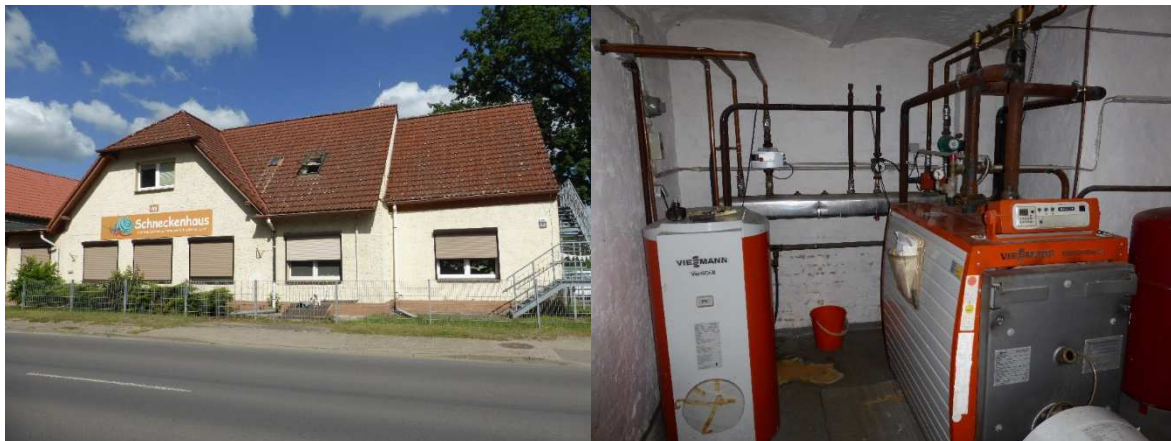
Abb. 15 Kita Schneckenhaus Zühlsdorf – Außenansicht und Heizungsanlage (re.)
