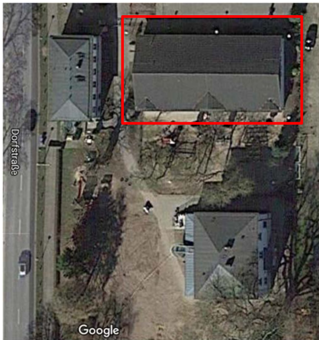
Abb. 21 geeignetes Gebäude zur Installation einer PV-Anlage
