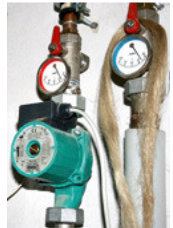
Dämmungen für Leitungen und Anschlüsse
