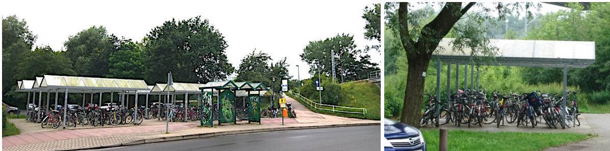
Abb. 35 B+R-Stationen Haltestelle Mühlenbeck-Mönchmühle
