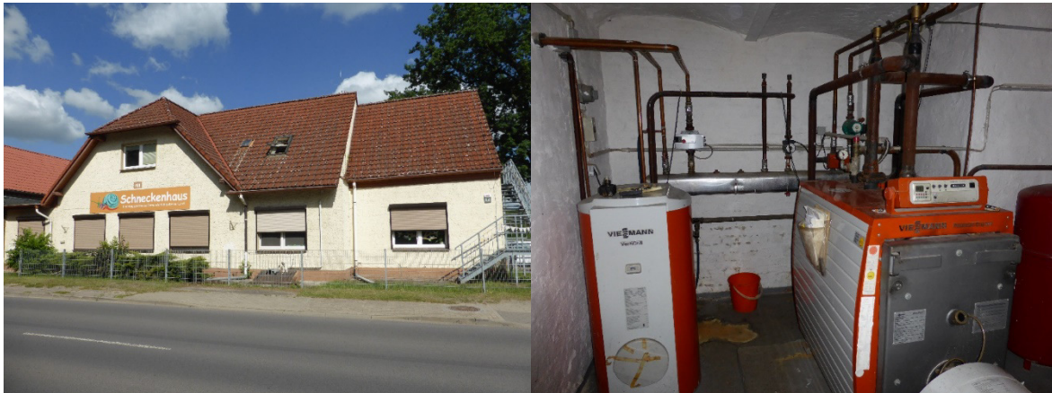
Abb. 15 Kita Schneckenhaus Zühlsdorf – Außenansicht und Heizungsanlage (re.)
