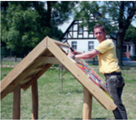
Montage der Holzhäuser in der Kita Raupe Nimmersatt
